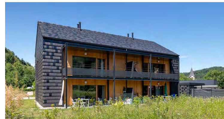
Logements sociaux bois-paille-passifs (88) © ASP Architecture & Terranergie
