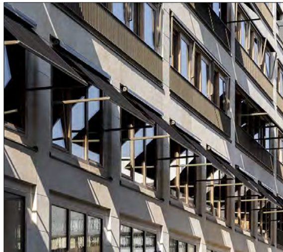
Immeuble mixte, ZAC de Beaujon [75] © NRAU
