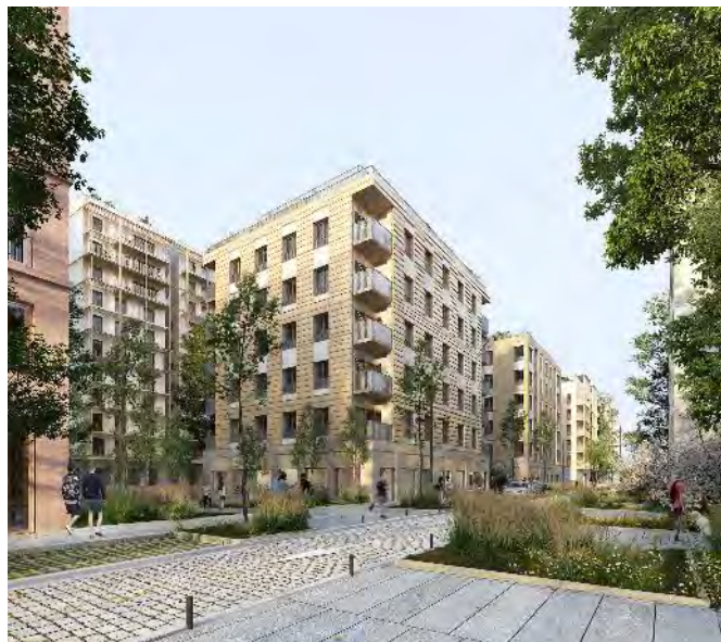
Village des Athlètes pour les Jeux de Paris, logements en structure bois
