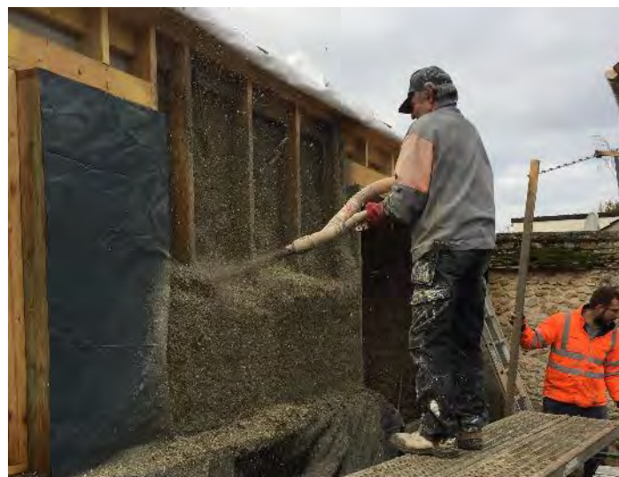
Projection de chanvre dans ossature bois
