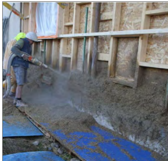
Rénovation d'un bâtiment viticole (67)
