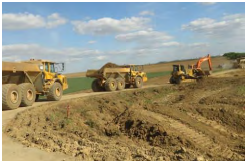
Excavation des terres du Grand Paris
