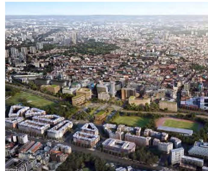
Porte de Montreuil, Zéro carbone sur 50 ans sur la construction
