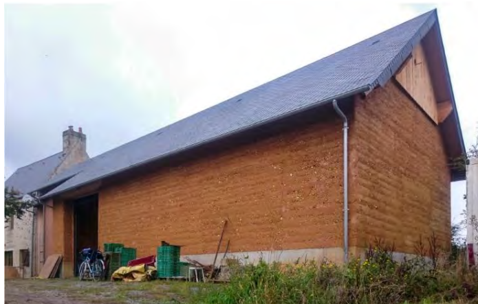
Bâtiment agricole - Saint Vigor le Grand (14)
