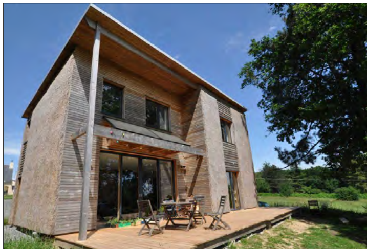
Maison individuelle avec isolation en roseau des murs, de la toiture et des façades (44)
