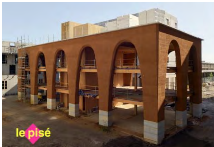
Bâtiment tertiaire en terre crue - îlot B2 Lyon Confluence (69)
