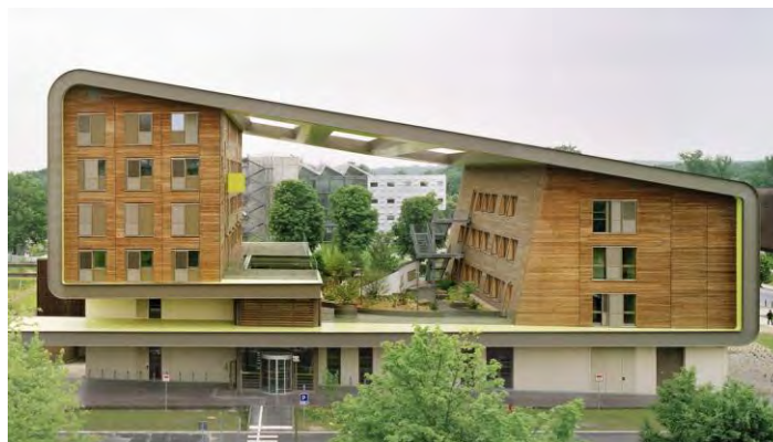
CORIOLI – ENPC Bâtiment Descartes [77]
