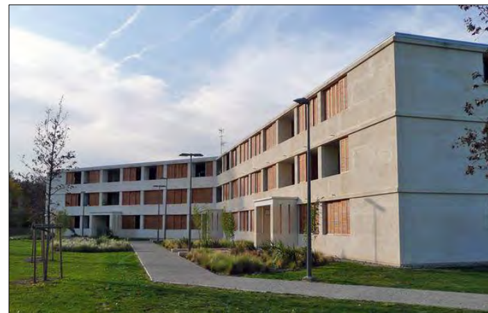
20 logements collectifs sociaux (31) © Le Moniteur
