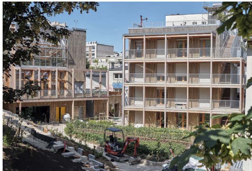
La ferme du Rail à Paris / Maîtrise d'ouvrage : Réhabail / Maîtrise d'oeuvre : Grand Huit Scop, architectes ; Mélanie Drevet, paysagiste / bois, paille, terre et réemploi
