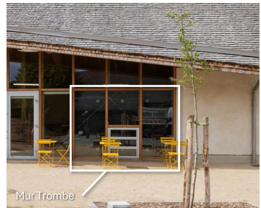
Arrière du mur Trombe en BTC
