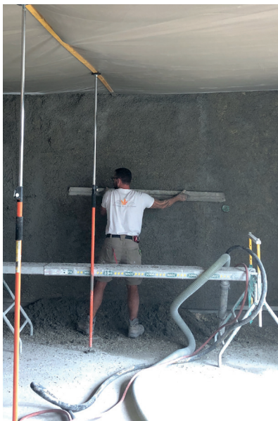
Projection chaux-chanvre au Val-de-la-Haye (76) par Aurélien Dubois (L'atelier terre & chaux)
