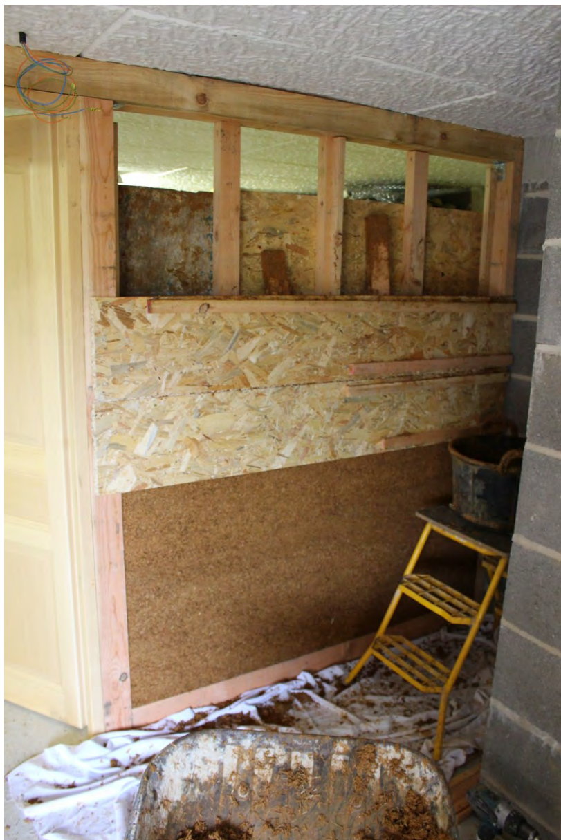
Figure 36: Test 2 : cloisonnement en terre allégée en cours. Photo : Jan Minne
