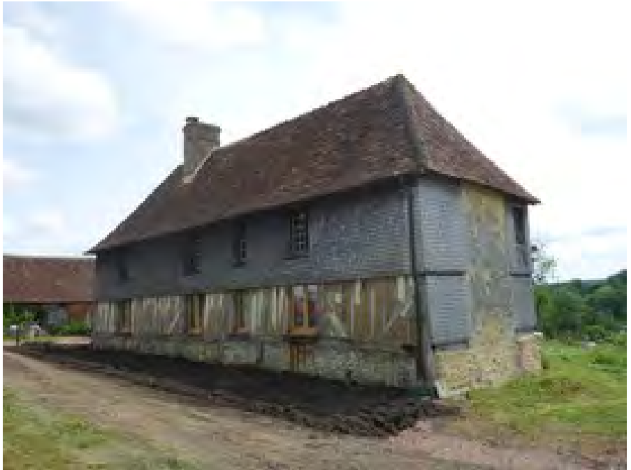
Figure 2: Bâtiment en pan de bois en préparation du remplissage terre chanvre. Photo : Ecopertica
