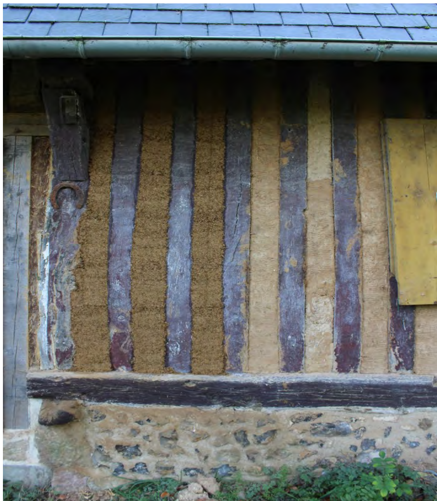
Figure 42: Essai en enveloppe vu de l'extérieur. Terre Lin décoffré à gratter pour faire un enduit à fleur du colombage vu de l'extérieur . Photo : Jan Minne
