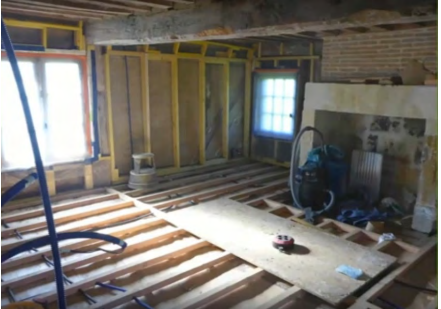
Figure 1: Chantier de projection terre / chanvre à l'intérieur. Photo: Ecopertica
