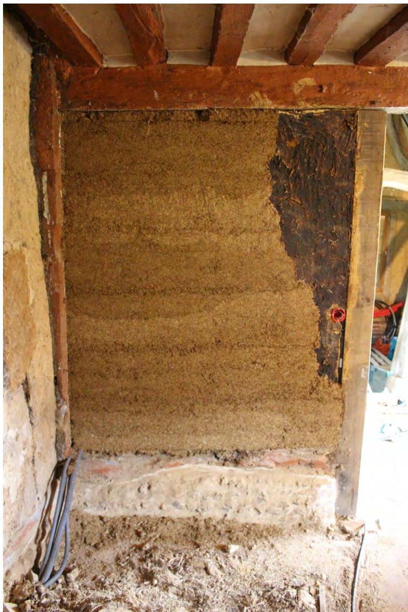
Figure 35: Test 1 de terre allégée en cloison intérieure. Photo : Jan Minne
