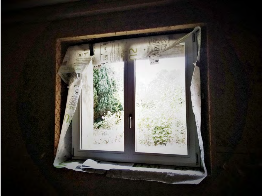
Figure 4: Bande de frein-vapeur en attente. Photo: Ecoperlica
