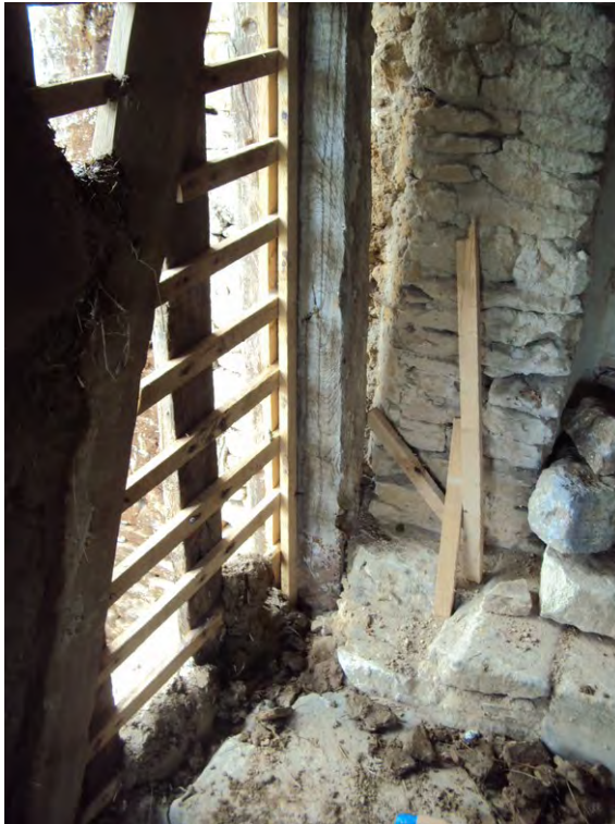
Figure 6: Lattage entre contre-lattes formant chicane. Chantier Grisy, Patrice Ieu. Auteur : Aurélie Le Pape
