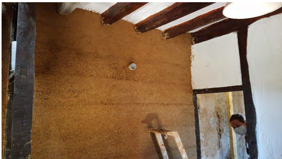
Figure 39: Terre-lin banché à Landigou. Photo: Anne Lequertier
