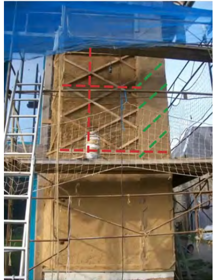
Figure 52: Principes de voile travaillant de la vannerie charpentière. Axes structurels soulignés en rouge et vert. Photo : Nicolas Maze
