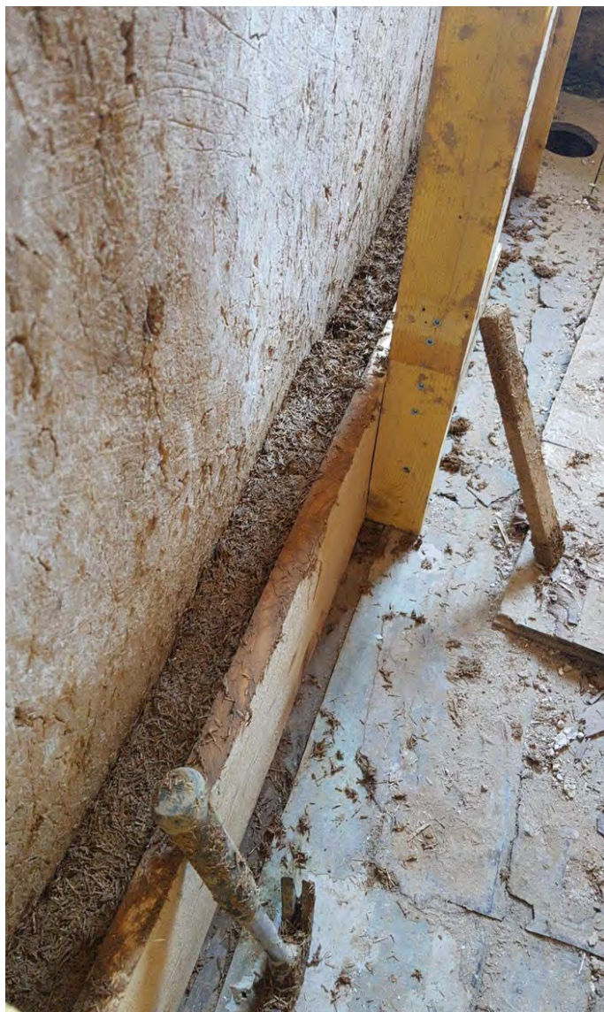
Figure 40: Terre Lin banché à Landigou. Photo : Anne Lequertier
