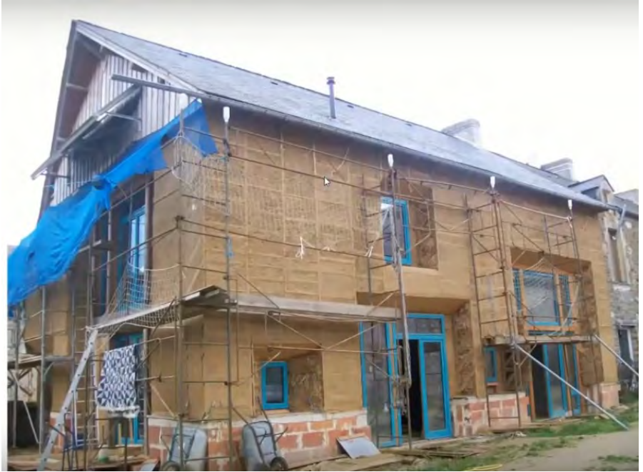
Figure 50: Chantier, isolation extérieure en bottes de paille support de vannerie charpentière. Photo : Nicolas Maze
