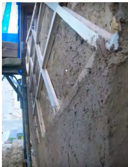
Figure 49: Vannerie Charpentièrerie et en bas mélange torchis frais posé. Photo : Nicolas Maze
