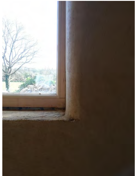
Figure 18: retour de tableau de la baie en arrondi. Photo : Guillaume Charrier
