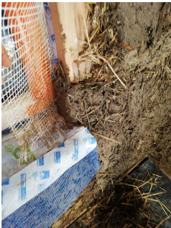
Figure 16: étanchéité à l'air soignée au pourtour de fenêtres. Chantier Soumont. Photo : Guillaume Charrier
