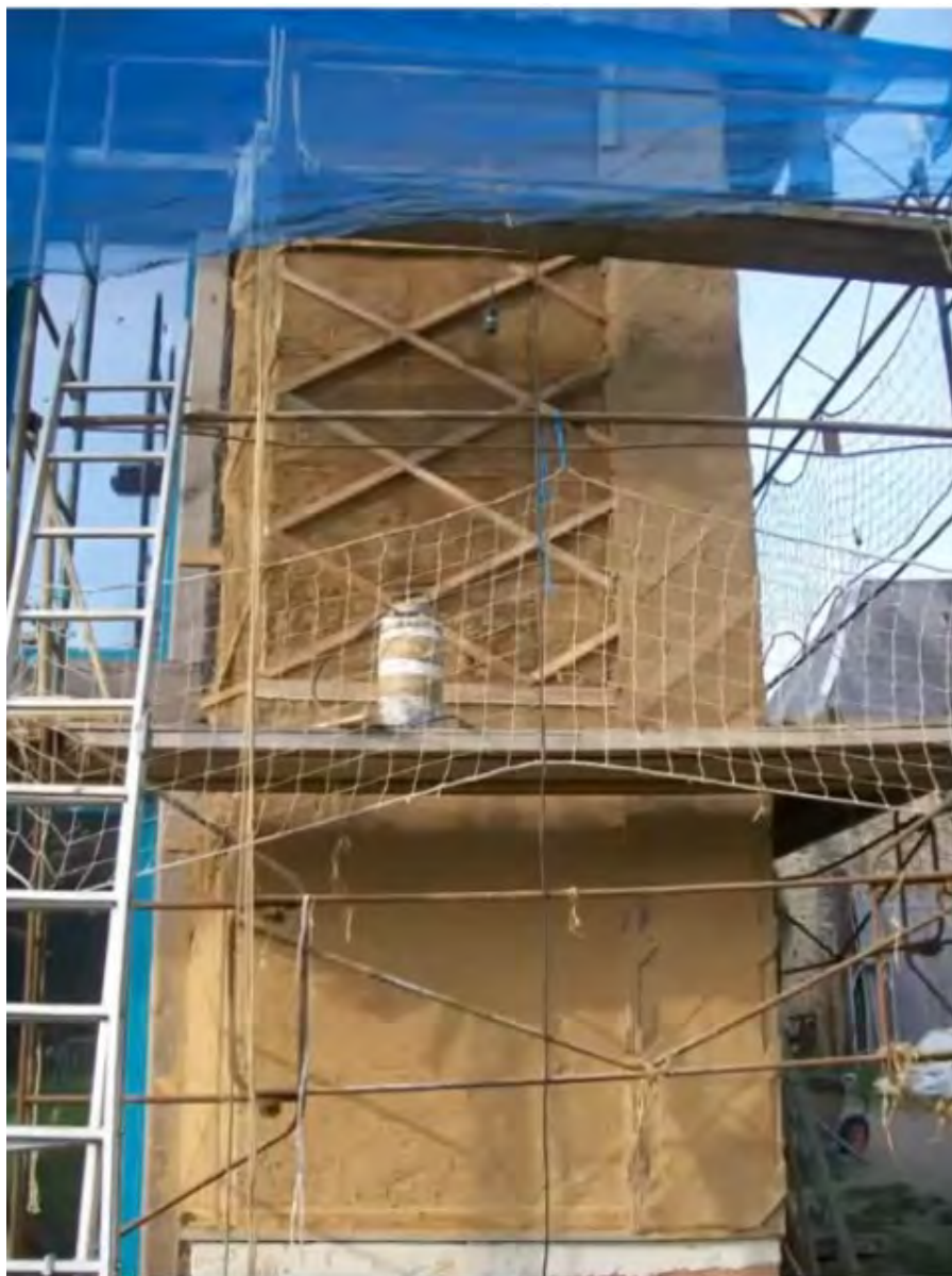
Figure 53: Système de voile travaillant à base de torchis et de petits bois -Photo : Nicolas Maze
