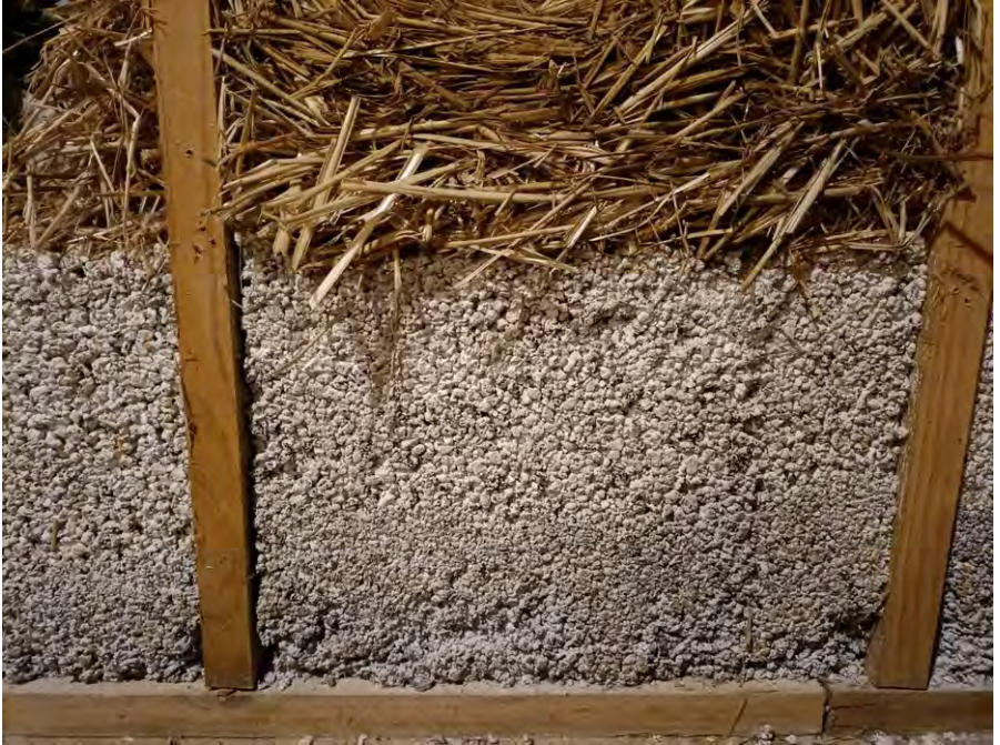
Figure 55: Pied de mur en chaux / liège en soubassement d'un doublage en terre allégée. Photo: Mylène Gajic
