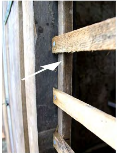
Figure 15: Contre latte visible avant pose du mélange. Auteur: Jan Minne
