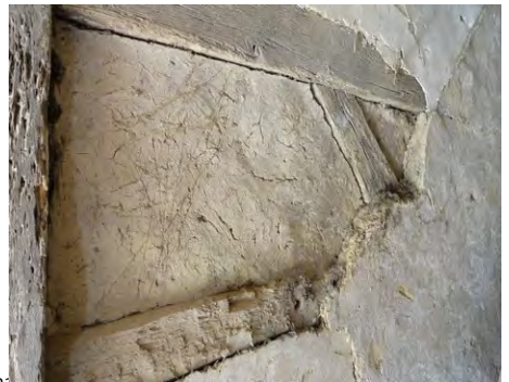
Figure 12: Pan de bois horizontal à trame lâche. Photo: Olivier Berthaut
