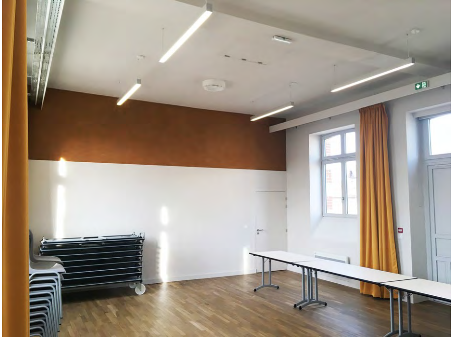
Figure 30: Microfilm de terre chanvre en partie haute d'un mur dans une salle polyvalente. Photo : Ecopertica
