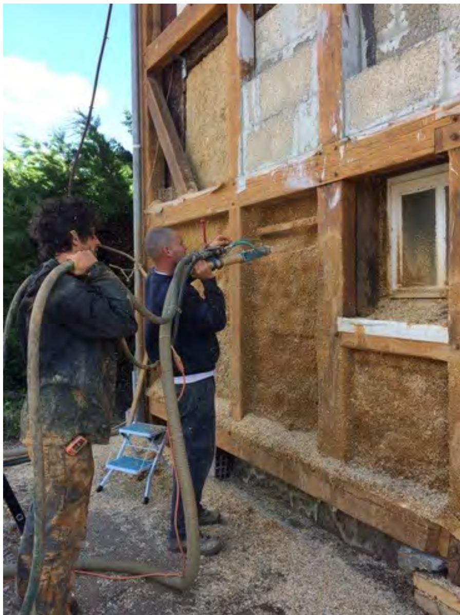
Figure 9: Projection sur contre ossature extérieure. Photo : Ecopertica
