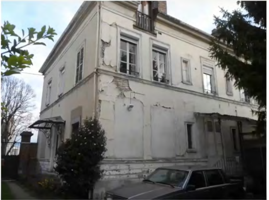
Figure 11: Enduit au Plâtre sur support type baccula en façade extérieure. Photo : Olivier Berthaut
