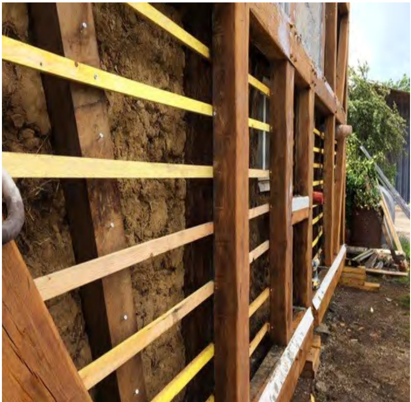
Figure 8: Système hybride support de fixation en isolation extérieure en attente projection terre – chanvre. Photo : Ecopertica
