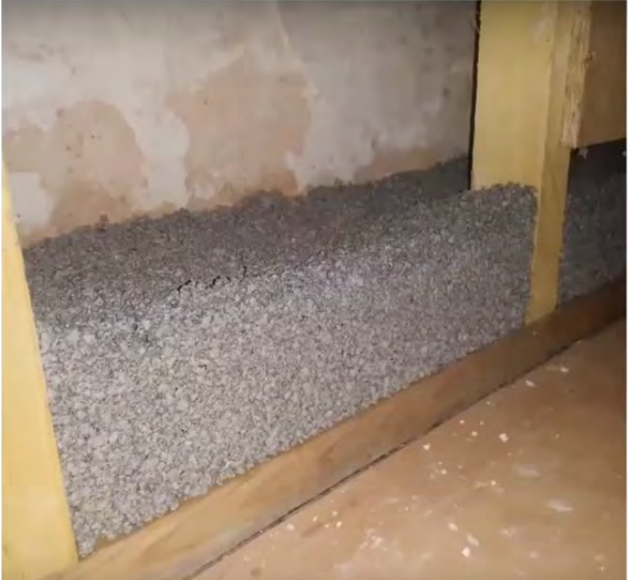
Figure 54: Mélange chaux-liège banché avec ossature. Photo : Mylène Gajic
