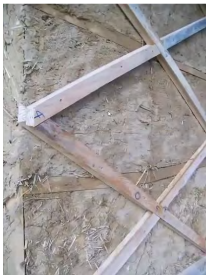
Figure 48: Vannerie charpentièrerie ou support de fixation des torchis. Photo : Nicolas Maze
