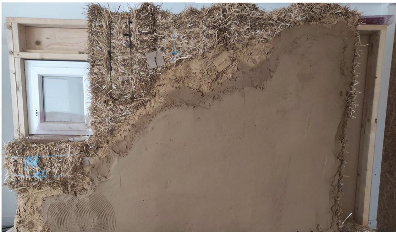
Module d'application d'un enduit terre sur support en bottes de paille lors d'une formation PRO-Paille, à Grand-Bourgtheroulde (27).
