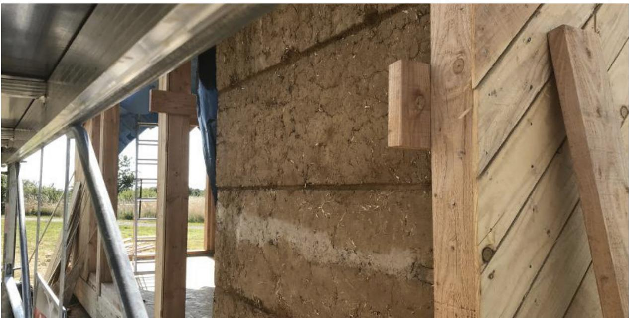
Blocs de bauge en place sur le chantier du pavillon démontable en 2019, à Saint-Côme-du-Mont (50). (© PATTE Erwan)
