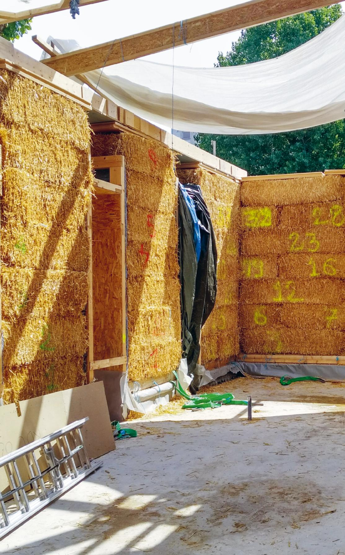
Mur en paille porteuse en cours de mise en œuvre
