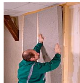
32 Pose de panneaux de ouate de cellulose
