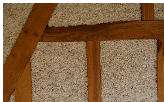
6 Béton de chanvre dans un colombage
