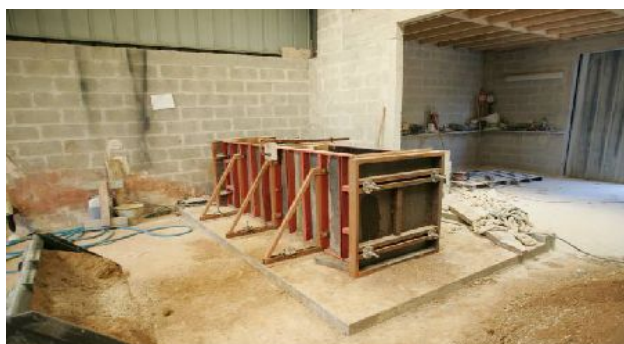
71 Coffrage de préfabrication, source F. Streiff
