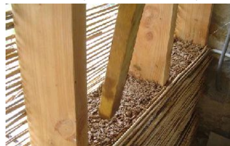
20 Isolation de cloison en copeaux de bois - source "Journal d'une construction écologique"
