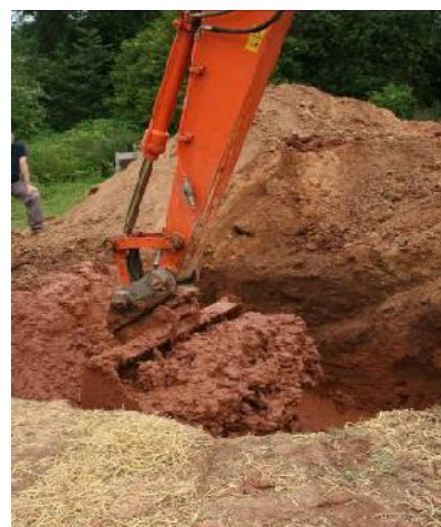
61 Préparation de la bauge à la pelleteuse
