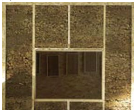
79 Terre coulée dans une ossature bois, Source «Pisé H 2 O », édition CRAterre
