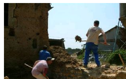
59 Démarrage d'un mur en bauge- crédit photo 'La terre crue en Basse-Normandie'
