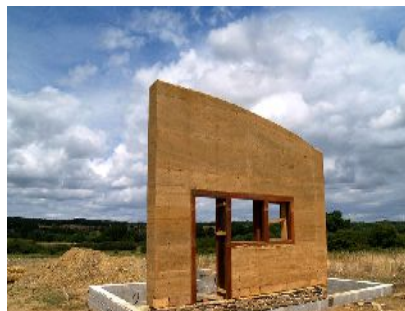
67 Mur en pisé levé – crédit photo http://storage.canalblog.com
