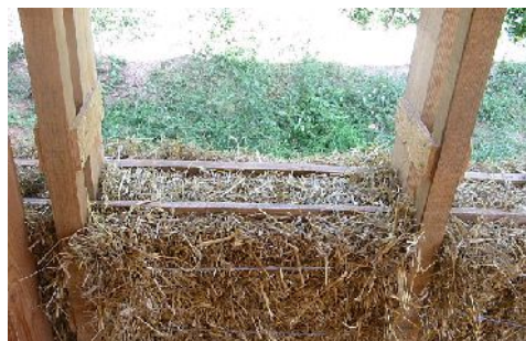
44 Fixation des liteaux pour comprimer les bottes - crédit photo http://aymes.over-blog.com
