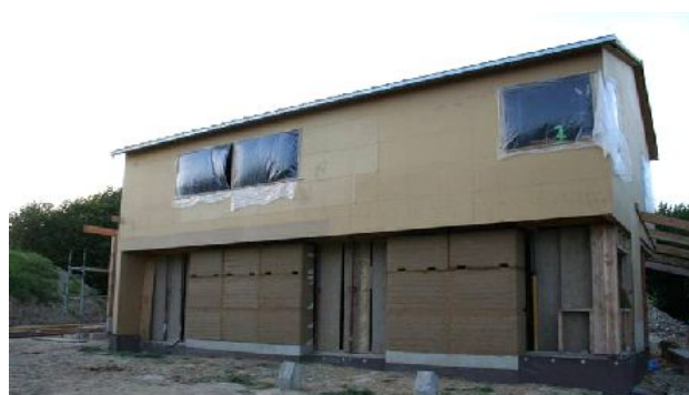
72 Murs en pisé préfabriqués, source F. Streiff
