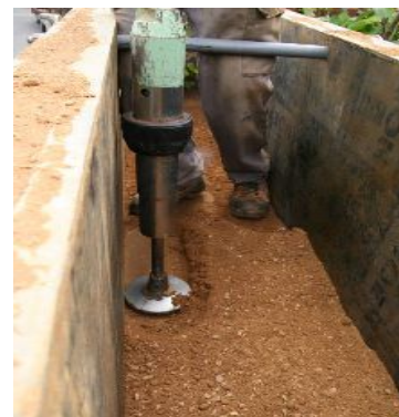
68 Damage du pisé avec un psoir pneumatique - source F. Streiff
