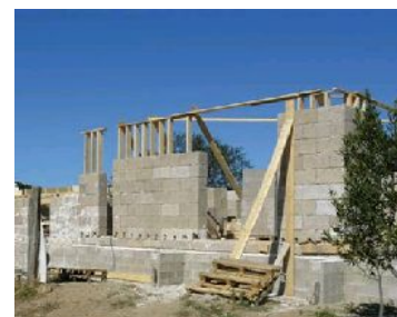
8 Construction en blocs de chanvre – Source www.batiproduit.com
