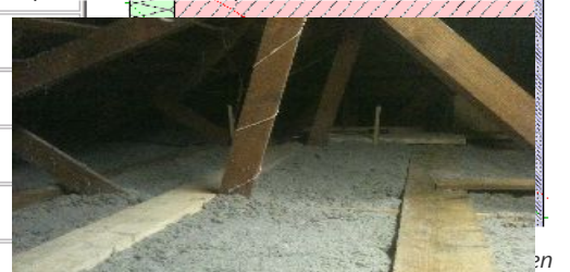
95 Combles isolés par flocage en ouate de cellulose - crédit photo
