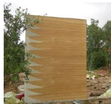
69 Mur en pisé stabilisé - crédit photo www.asterre.org
