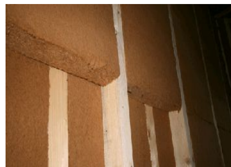
86 Isolation et doublage d'isolation en laine de bois – source www.sgmo-construction.fr
