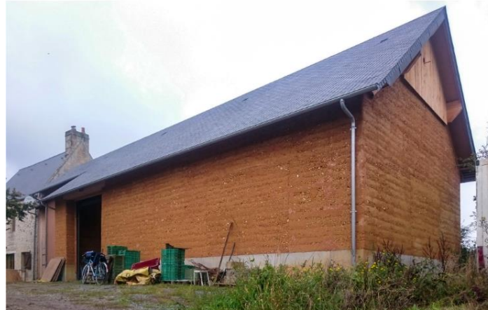
Bâtiment agricole - Saint Vigor le Grand (14)
