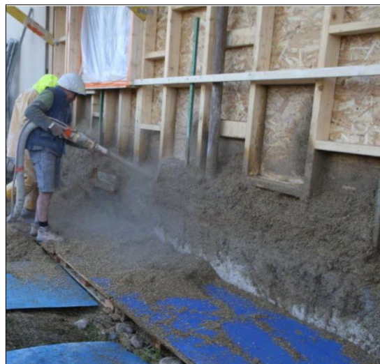
Rénovation d'un bâtiment viticole (67)
