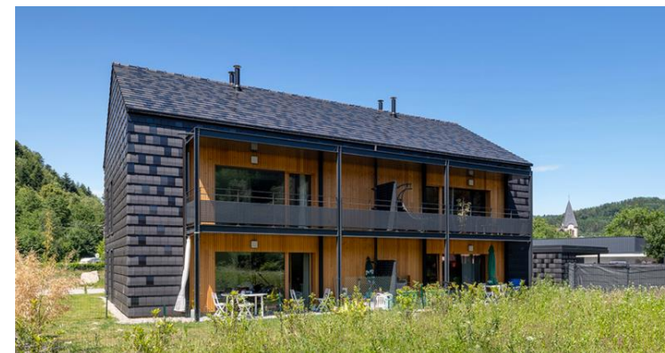
Logements sociaux bois-paille-passifs (88) © ASP Architecture & Terranergie
