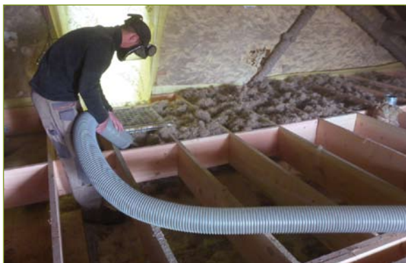
Soufflage de laine en combles perdus. Dans le cas présent, un lambourrage a été installé pour permettre de fermer les caissons en cas d'utilisation des combles à des fins de stockage.
