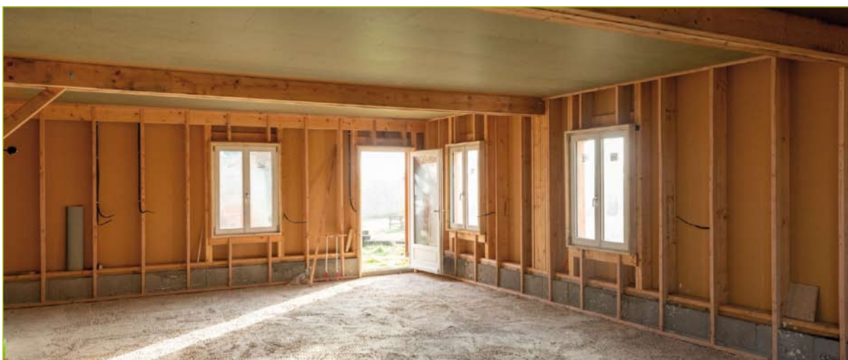
Ossature bois porteuse prête à recevoir l'isolant.
