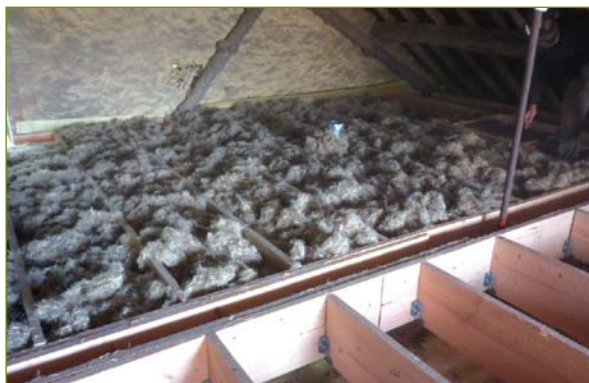
Soufflage de laine en combles perdus. Dans le cas présent, un lambourrage a été installé pour permettre de fermer les caissons en cas d'utilisation des combles à des fins de stockage.
