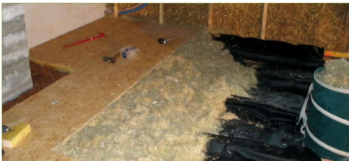
Isolation d'un plancher en laine de chanvre.
