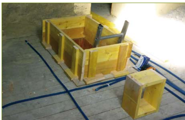
Une réhausse de trappe est conçue pour contenir l'isolant autour de la trémie. Un piétement est également prévu pour accueillir des planches horizontales qui serviront de chemin d'accès aux combles.
