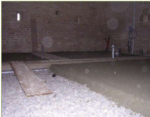
Dalle chaux-chanvre sur hérisson ventilé.
