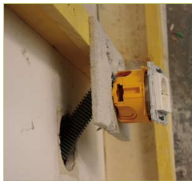
Le boîtier électrique est fixé sur un support rigide en attente d'une mise en oeuvre par voie humide. Le tout est ajusté pour que la prise arrive à fleur de la couche de finition.
