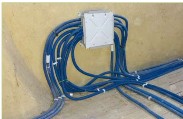
Les réseaux sont préparés avant l'isolation des combles. Le boîtier de dérivation a été posé de telle manière à ce qu'il soit au dessus de l'isolant.
