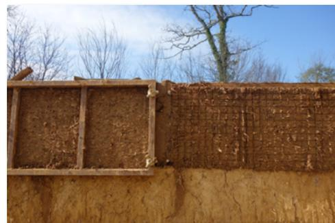
Le mélange peut être mécanisé en utilisant un malaxeur. On peut également le réaliser directement à la pelleuse : on malaxera en utilisant le godet et en roulant sur le mélange, puis l'application peut être effectuée directement au godet sur le mur. La suite du processus (resserrage et découpage) est effectuée suivant la méthode traditionnelle.
