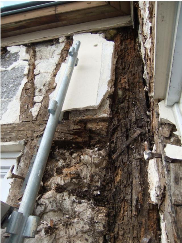
*Façade d'un bâtiment en colombages vu en 2010 après piquetage d'un enduit ciment : les bois sont très dégradés car le ciment n'est pas adapté à ce bâti ancien.*
