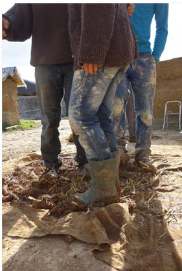
Traditionnellement, la terre et la paille sont dosées en pourcentage, puis le mélange est réalisé par foulage au pied et retourné à la fourche ou à la pelle. La bonne quantité d'eau est ajoutée au fur et à mesure pour faciliter le mélange sans dépasser l'état plastique de la terre. La bauge ainsi obtenue est appliquée à la fourche par mottes croisées sur le mur, en levées de 50 cm à 1,20m en fonction de la qualité de la terre, du mélange et de l'application.
