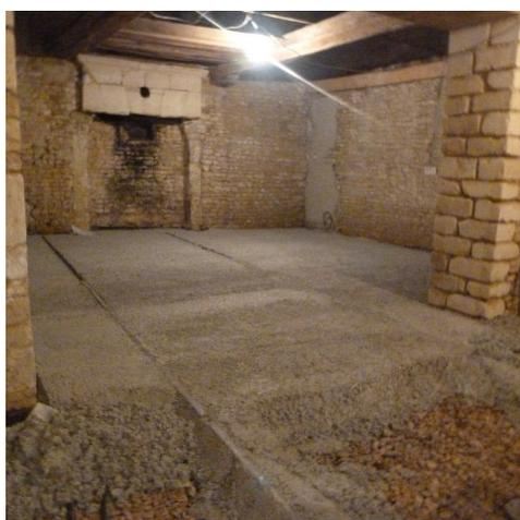
Illustration 36: Dalle chaux-liège en cours de réalisation sur un hérisson ventilé. Crédits : Guêpes Maçonnes
