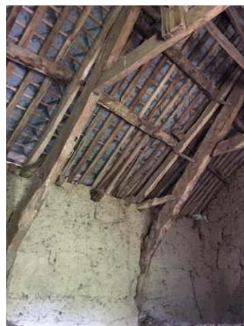
*Illustration 7: pièce de charpente naturellement courbée au niveau de sa pénétration dans un mur en bauge dans une bâtisse d'Ille et Villaine*
