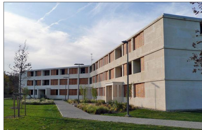
20 logements collectifs sociaux (31) © Le Moniteur
