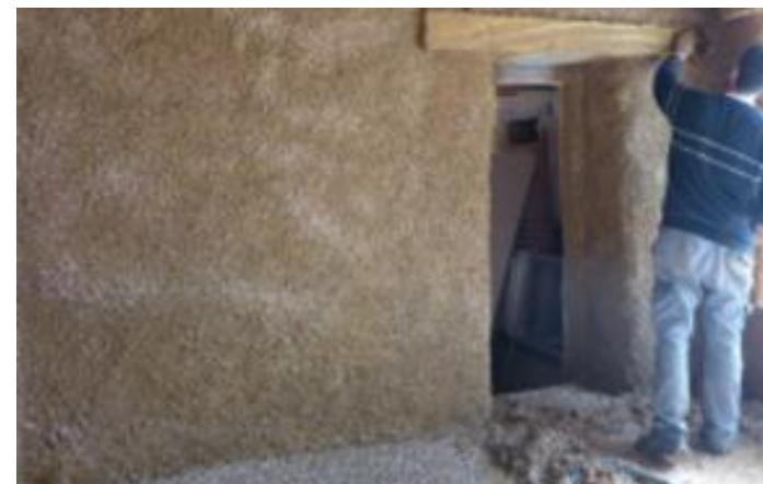
Rénovation énergétique d'une maison traditionnelle du Perche à niveau BBC
