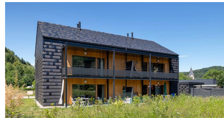
Logements sociaux bois-paille-passifs (88) © ASP Architecture & Terranergie
