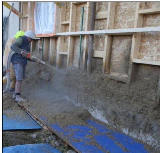
Rénovation d'un bâtiment viticole (67)
