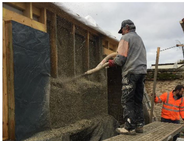
Projection de chanvre dans ossature bois
