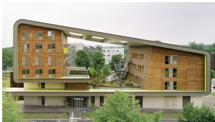
CORIOLI – ENPC Bâtiment Descartes [77]
