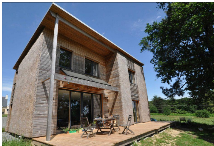
Maison individuelle avec isolation en roseau des murs, de la toiture et des façades (44)
