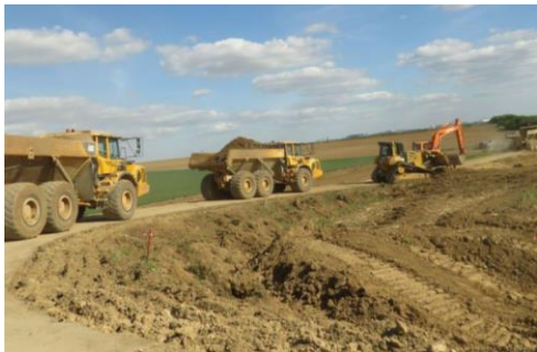
Excavation des terres du Grand Paris
