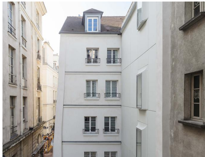
Réhabilitation et extension d'un immeuble du XVIIIème (75) @ DLA
