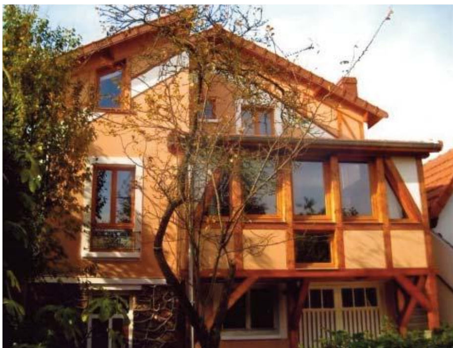
Maison d'habitation Sevrans. Surélévation-extension pour gagner trois pièces, et isolation radicale de la maison. 30 cm de chènevotte en vrac dans les rampants de toiture. Architecte Jean-Marc Naumovic
