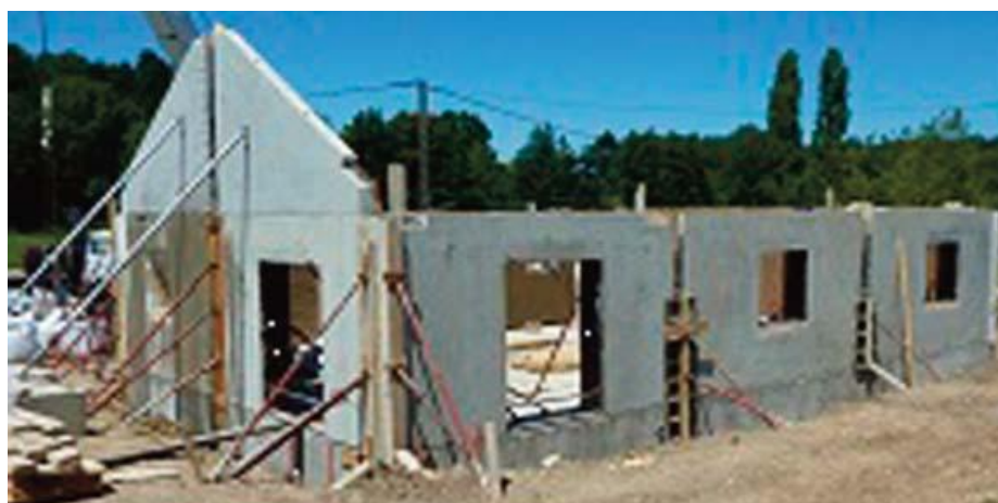
Assemblage de voiles béton de chanvre + béton léger. Crédit photo MNBC
