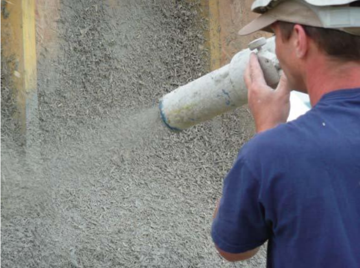
Projection mécanique par machine sur une banche.
