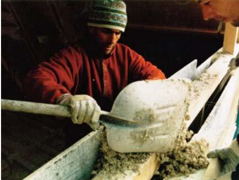
Déversement manuel entre deux banches.
