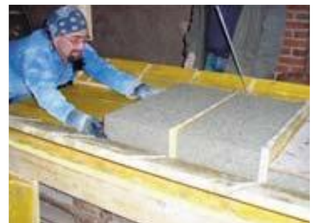
Unité de fabrication de blocs de béton de chanvre Construir'Eco
