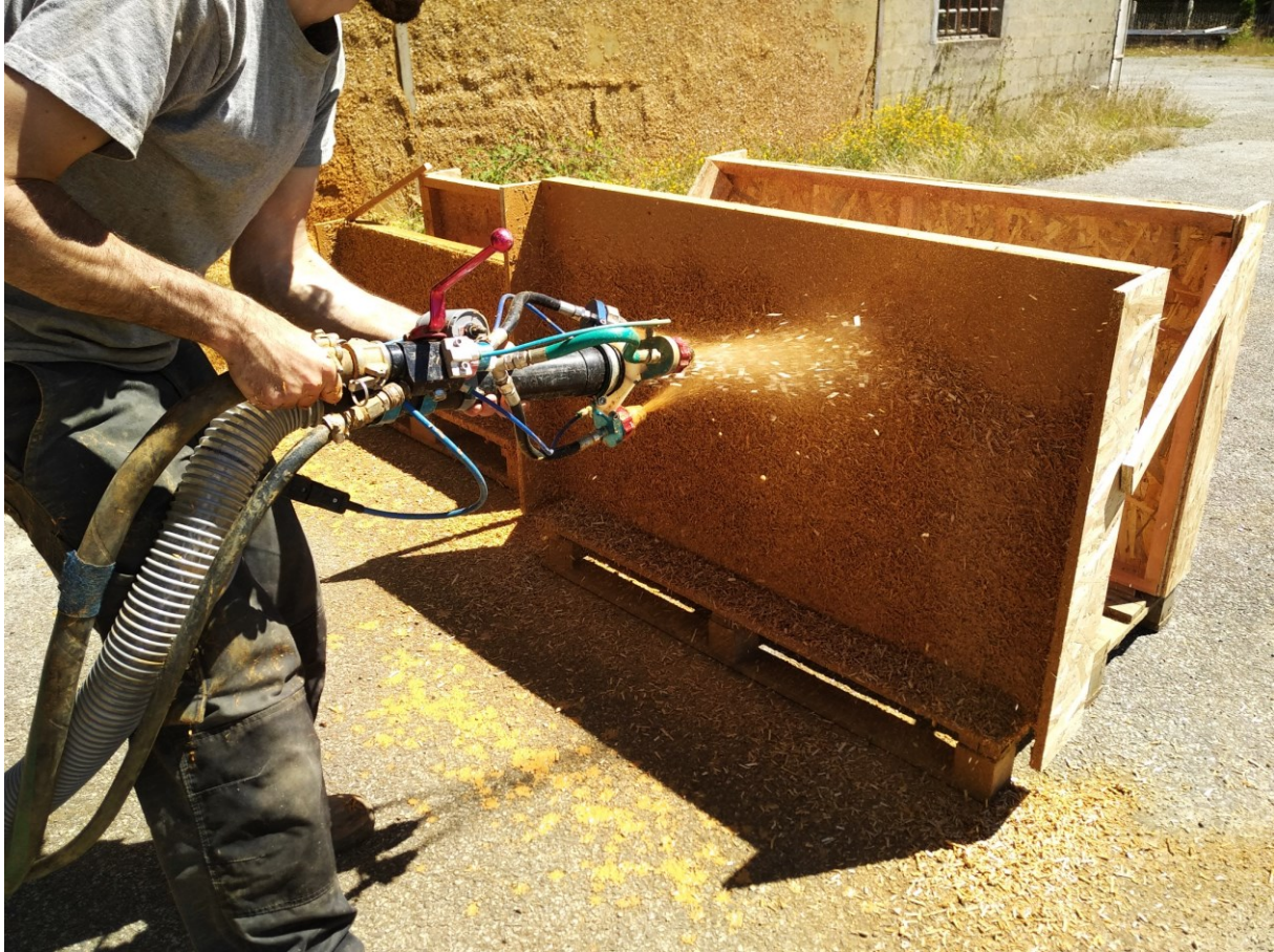
Figure 3-7: Fabrication d'échantillon de terre-chanvre par projection.
