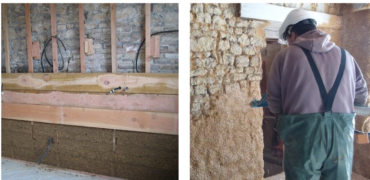
Figure 0-7: Exemple de chantier de terre chanvre. Gauche, banchage ; droite, projection. (Crédits_ A. Hellouin de menibus)
