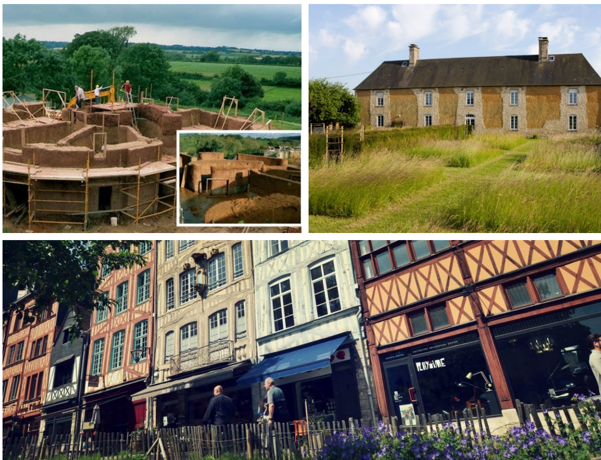
Figure 0-5: De gauche à droite et de haut en bas: chantier de bauge en Angleterre (2011); habitat vernaculaire de la manche en bauge; bâtiments pans de bois et torchis à Rouen [43–45].
