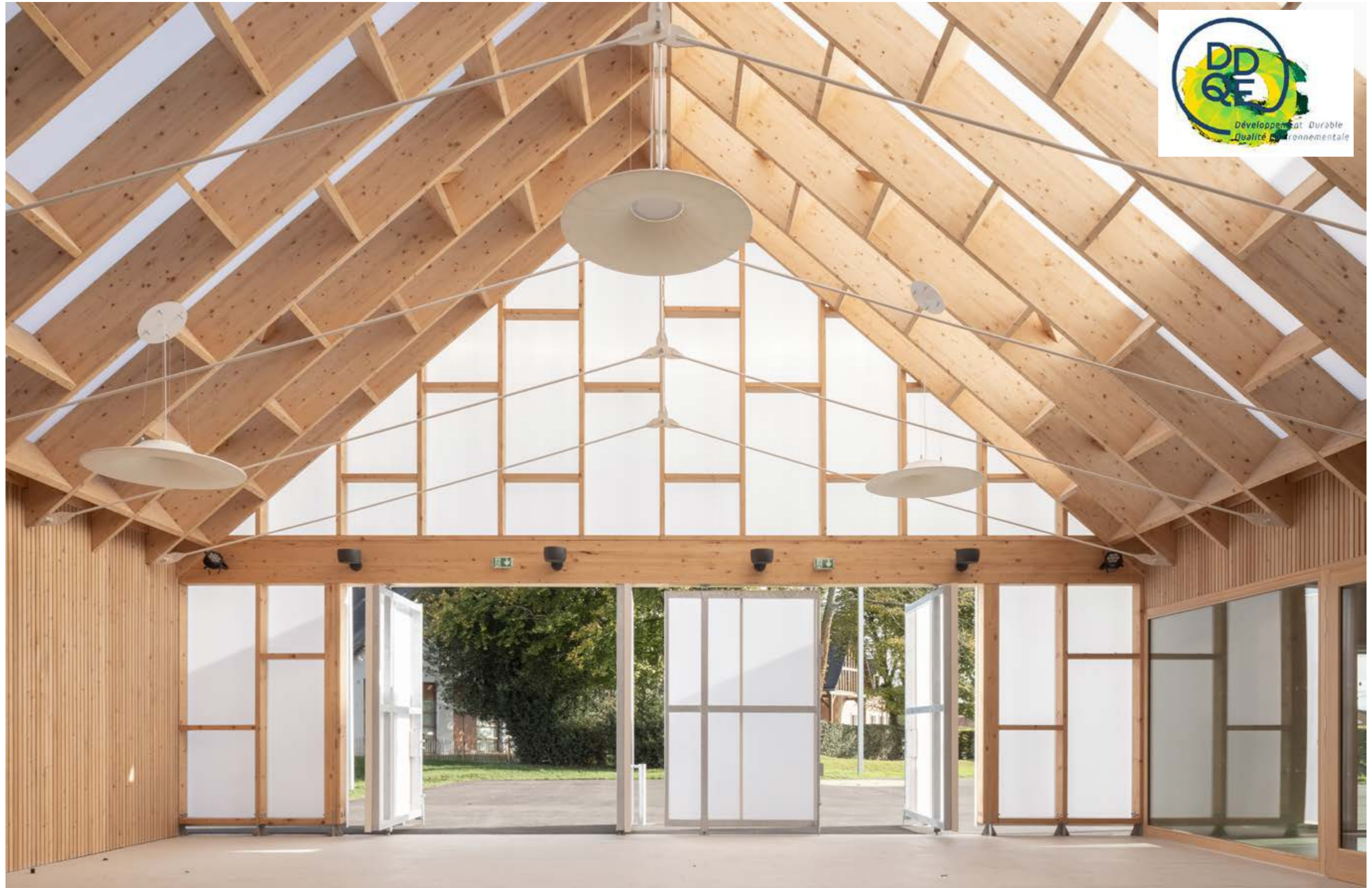
ECOLE MATERNELLE - SAINT OUEN DU TILLEUL - OSSATURE BOIS - HQE
