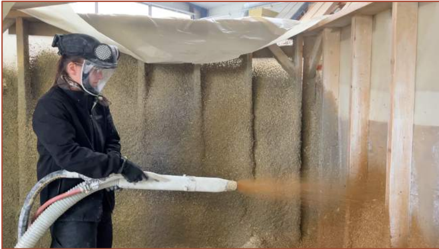
Projection mécanisée de terre-chanvre © L'atelier Terre et Chaux
