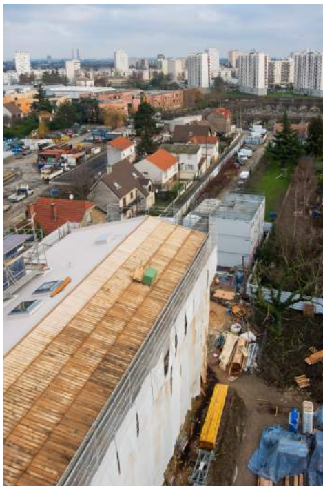
Toiture en bardeaux de chêne
