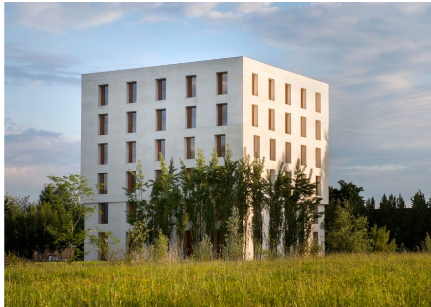
Bureaux 2226 à Lustenau / Maîtrise d'ouvrage : Baumschlager Eberle / Maîtrise d'œuvre : Baumschlager Eberle / conception passive bioclimatique : monolithe en briques monomur, ouvertures réduites, ventilation naturelle, chauffage par sources de chaleur existantes
