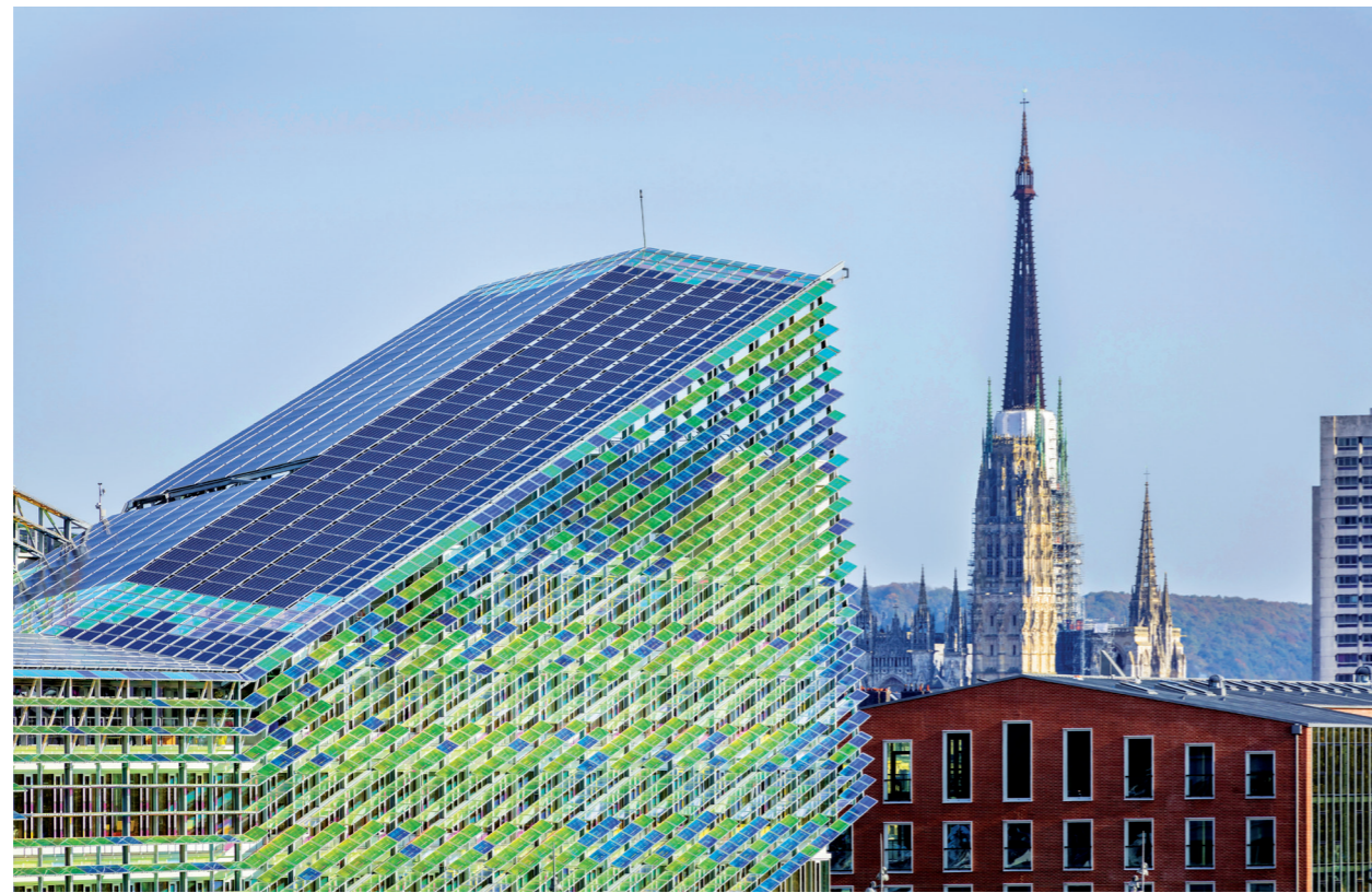
Le 108, siège de la Métropole Rouen Normandie, est un bâtiment à énergie positive. Il produit 300 MWh par an.
